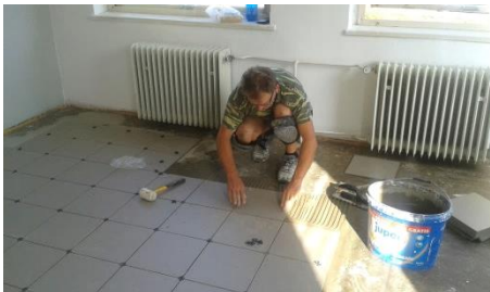
Prebiehajúca oprava školskej jedálne
